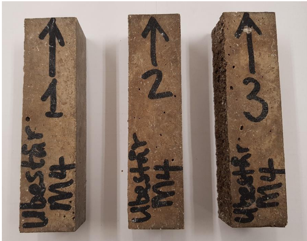
Figur 15 Foto på prismor med material från Malmö M4 efter avslutad provning med NT Build 295. Prismorna visar tecken på sprickor och enstaka pop-outs.
